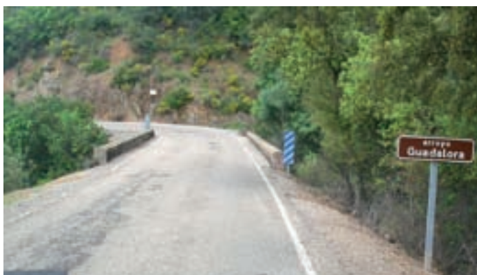
Fotografía 15. Puente de la Esira, sobre el Arroyo Guadaluza. MMC
