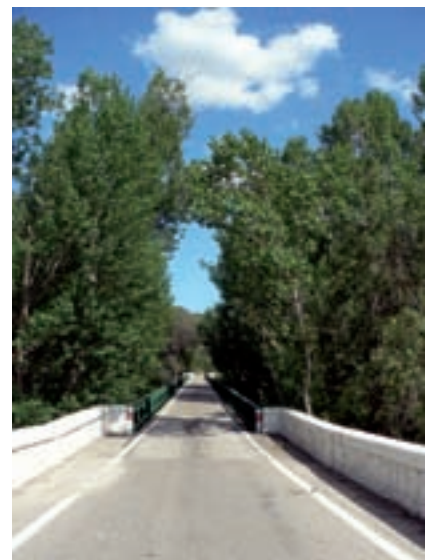
Fotografía 4. Puente sobre el río Jándula. RPA
