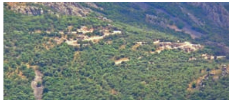
Fotografía 6. Tramo tortuoso de la carretera a Aldeaquemada. MMG
